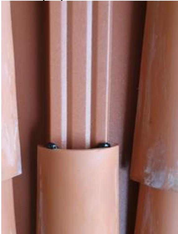
2 plots mastic-colle devront être d'un volume conforme au § 2.4.5.2.1 de l'Avis Technique 5.1/23-2591 posé entre le bac et l'arrière de la tuile
