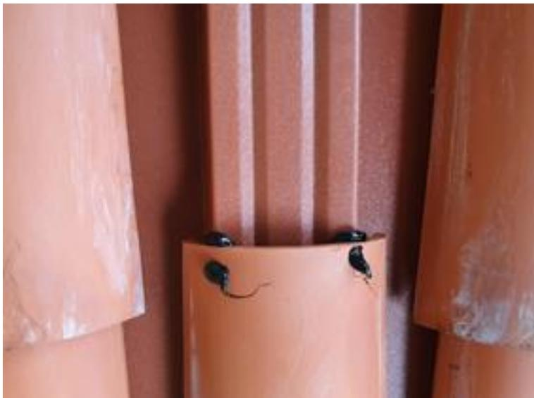
2 plots mastic-colle devront être d'un volume conforme au § 2.4.5.2.1 de l'Avis Technique 5.1/23-2591 posé au recouvrement des tuiles
